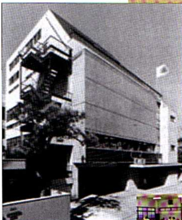
L'Aïkikai vu depuis la rue.
